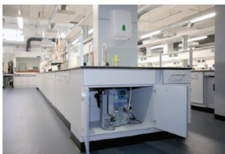
一台泵，多个使用者：安装带有电子冷凝器的泵，无需连接循环水收集溶剂
