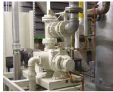
Zentralvakuumanlage
