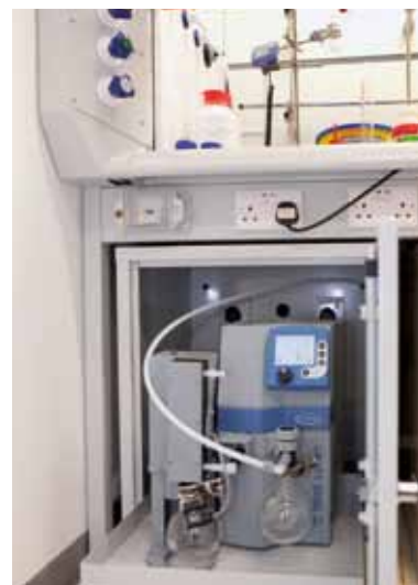
Chemie-Netzwerkpumpstand unter dem Abzug, mit Lösemittelrückgewinnung
