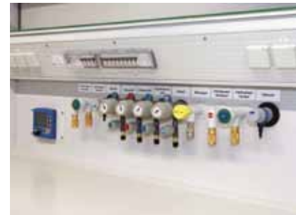
Controller-Installation innerhalb der Mediensäule
