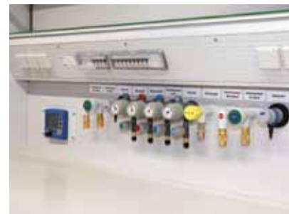
Installation du régulateur dans la colonne de distribution des fluides
