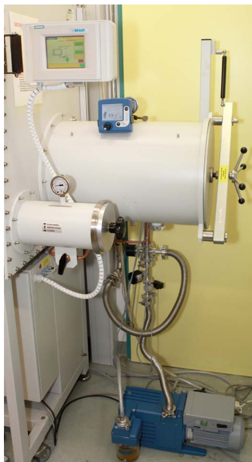
Figura 2: Cámara de transferencia de una caja de guantes con bomba de vacío y vacuómetro
